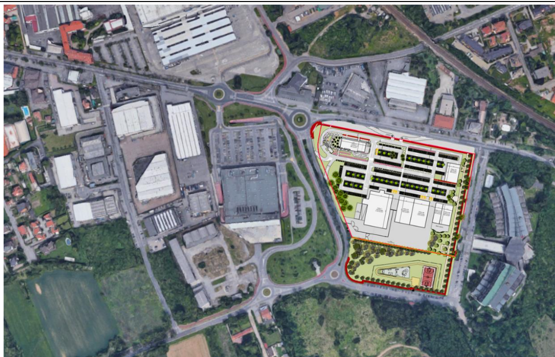
Vista da sud del sito in oggetto
