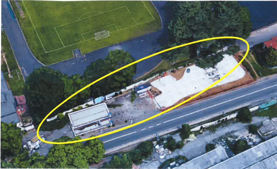
Vista satellitare 2D - particolare Individuazione planimetrica muro recinzione stadio "Giovanni Provasi" su S.S. N°33 – vista da esterno stadio
