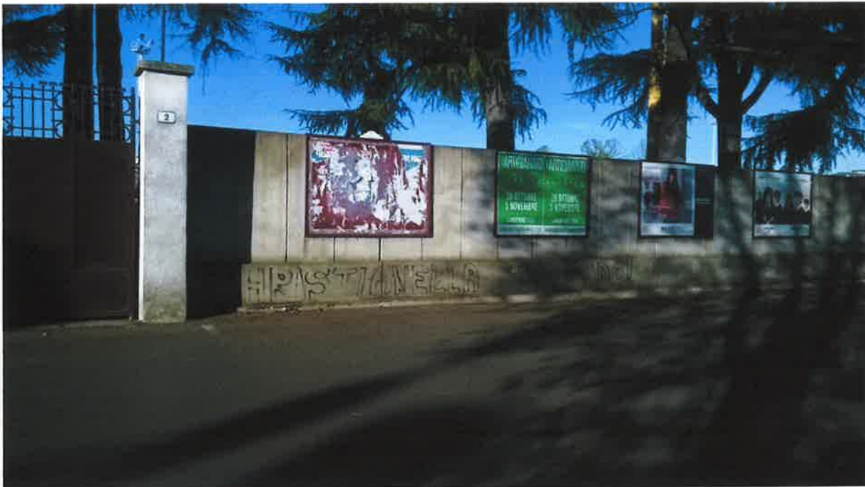
Foto n°1 Particolare recinzione su Via Armando Diaz Vista da esterno stadio
