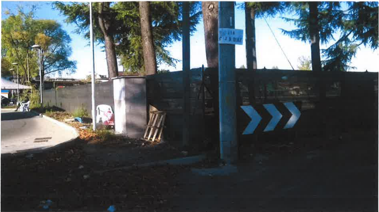
Foto n°4 Particolare recinzione su Via Armando Diaz ang. piazzale stazione di servizio su S.S. N°33 Vista da esterno stadio
