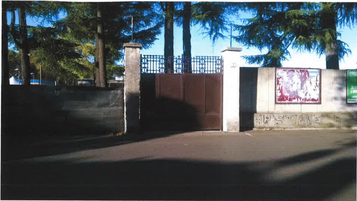
Foto n°2 Particolare recinzione su Via Armando Diaz Vista da esterno stadio
