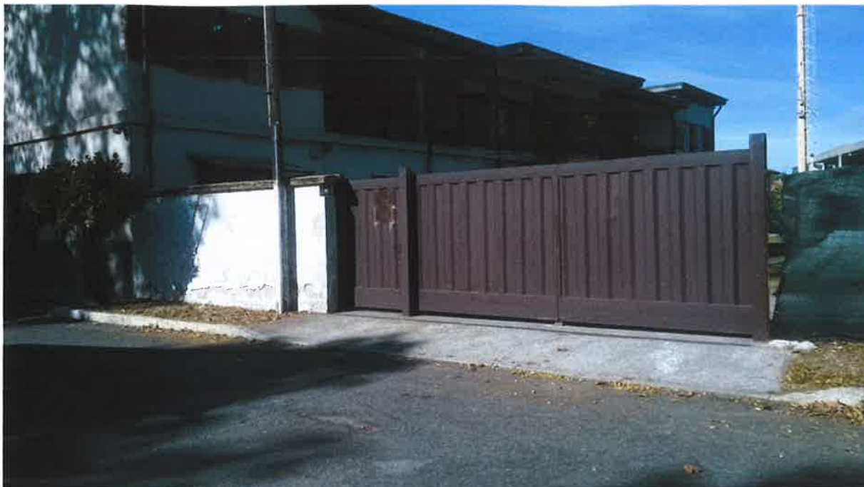
Foto n°8 Particolare recinzione su piazzale stazione di servizio su S.S. N°33 Vista da esterno stadio
