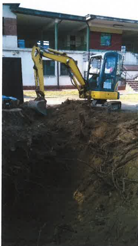
Foto n°11 Particolare recinzione su piazzale stazione di servizio su S.S. N°33 Vista da interno stadio – Saggio in corrispondenza essenze arboree da rimuovere
