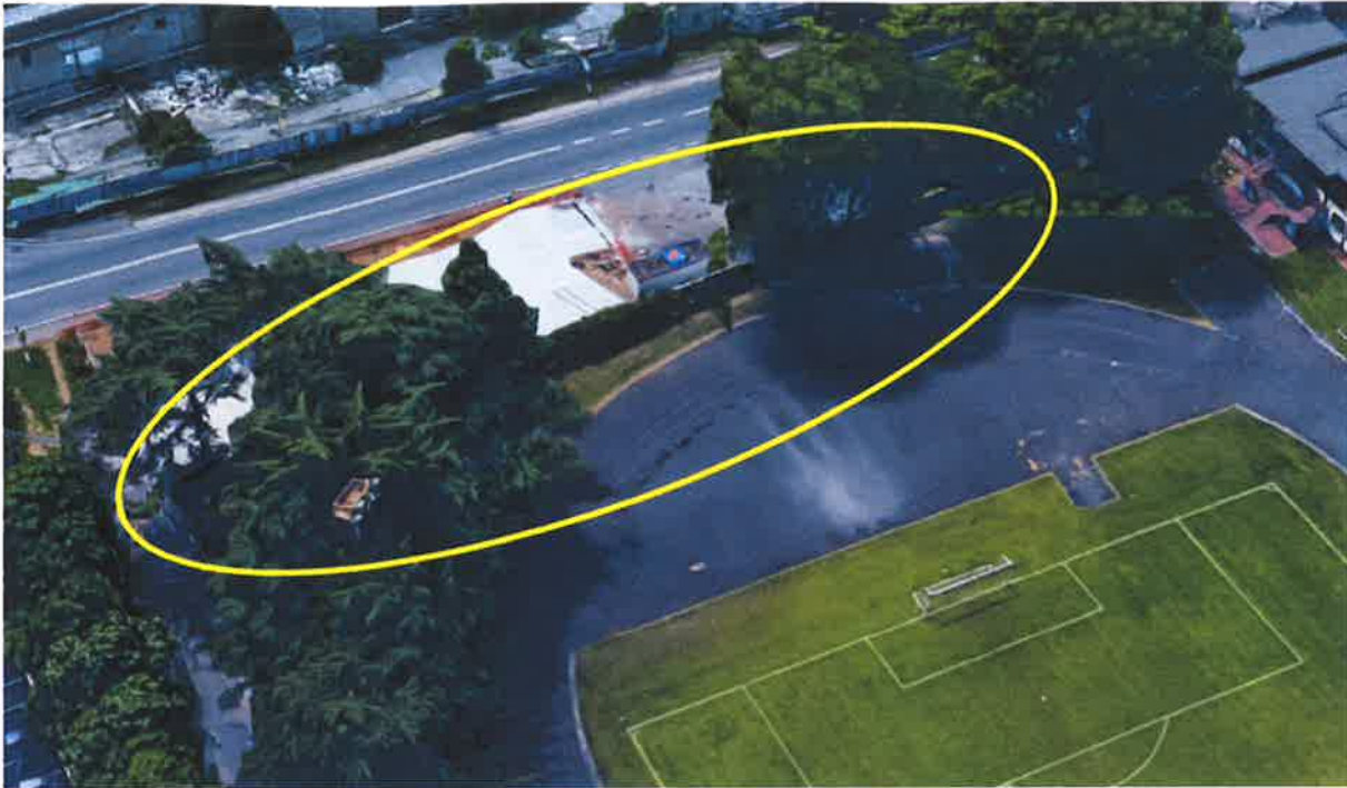
Vista satellitare 3D - particolare Individuazione planimetrica muro recinzione stadio "Giovanni Provasi" su Via Armando Diaz e S.S. N°33 – vista da interno stadio
