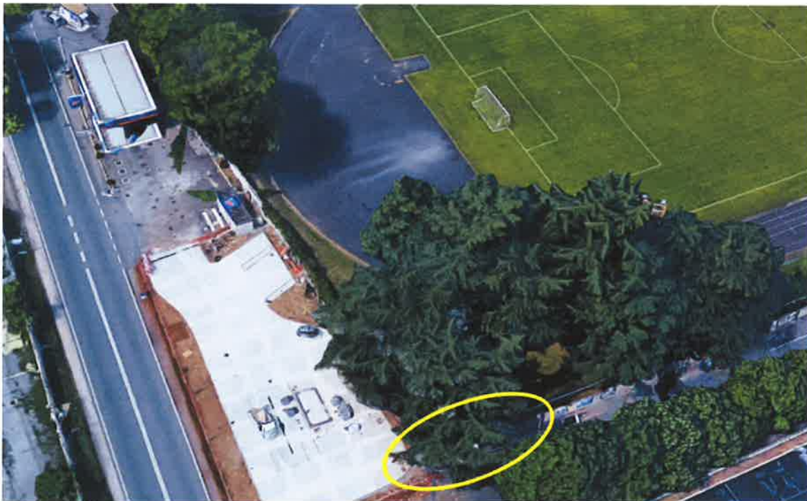
Vista satellitare 2D - particolare Individuazione planimetrica muro recinzione stadio "Giovanni Provasi" su Via Armando Diaz – vista da esterno stadio
