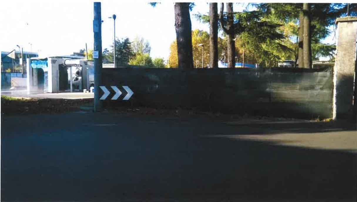
Foto n°3 Particolare recinzione su Via Armando Diaz Vista da esterno stadio
