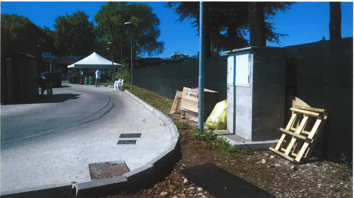
Foto n°5 Particolare recinzione su piazzale stazione di servizio su S.S. N°33 Vista da esterno stadio
