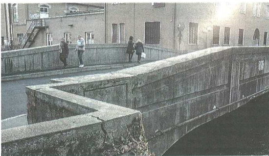
Il ponte di Castegnate, simbolo del rione che chiede attenzione dal Comune (Bilaz)
