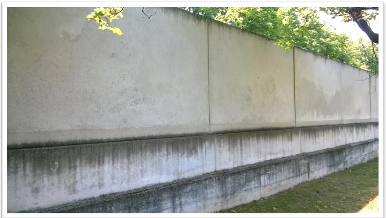
Figura 3 - - lato interno recinzione via Diaz
