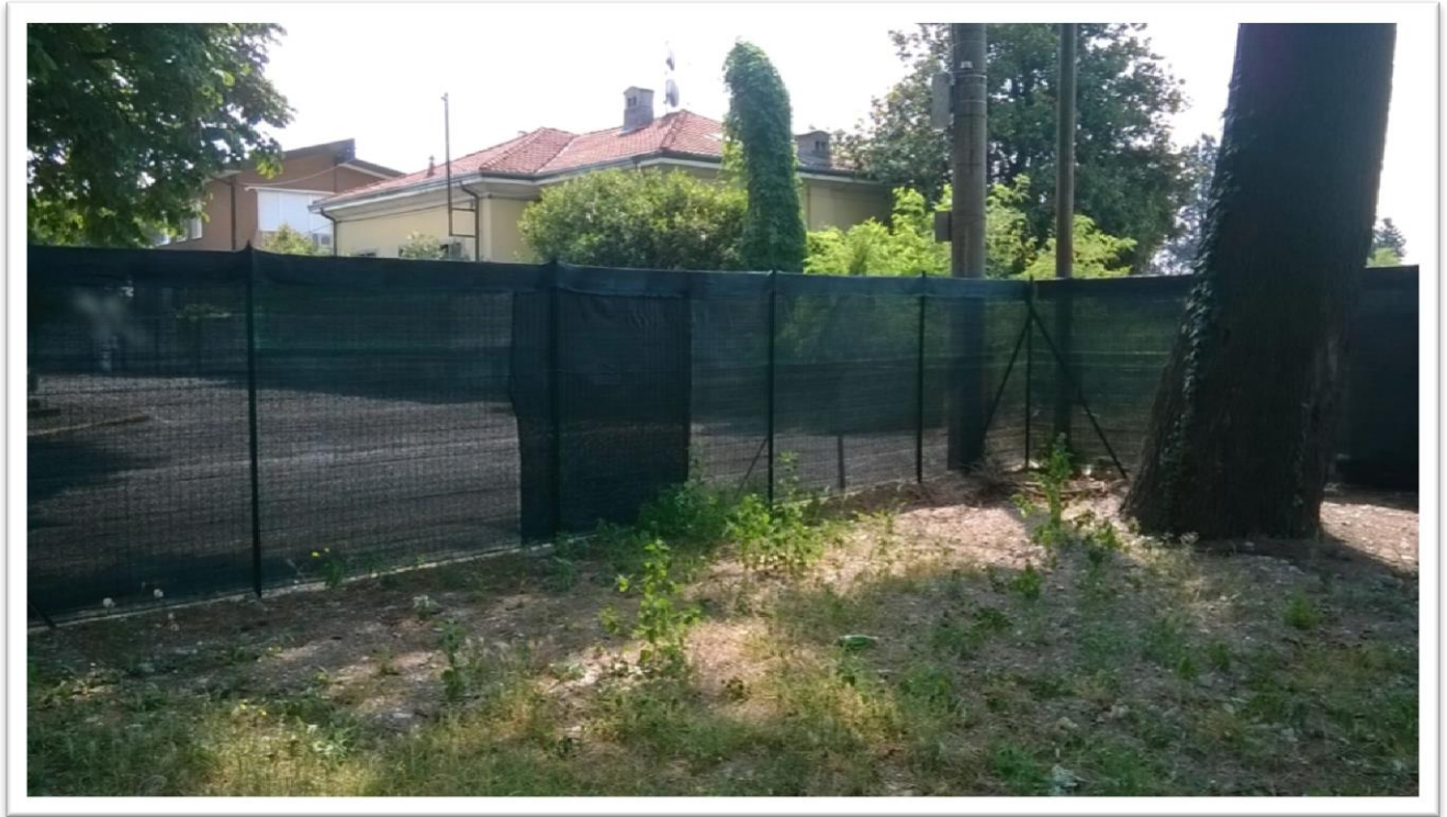
Figura 4 - - lato interno recinzione provvisoria via Diaz
