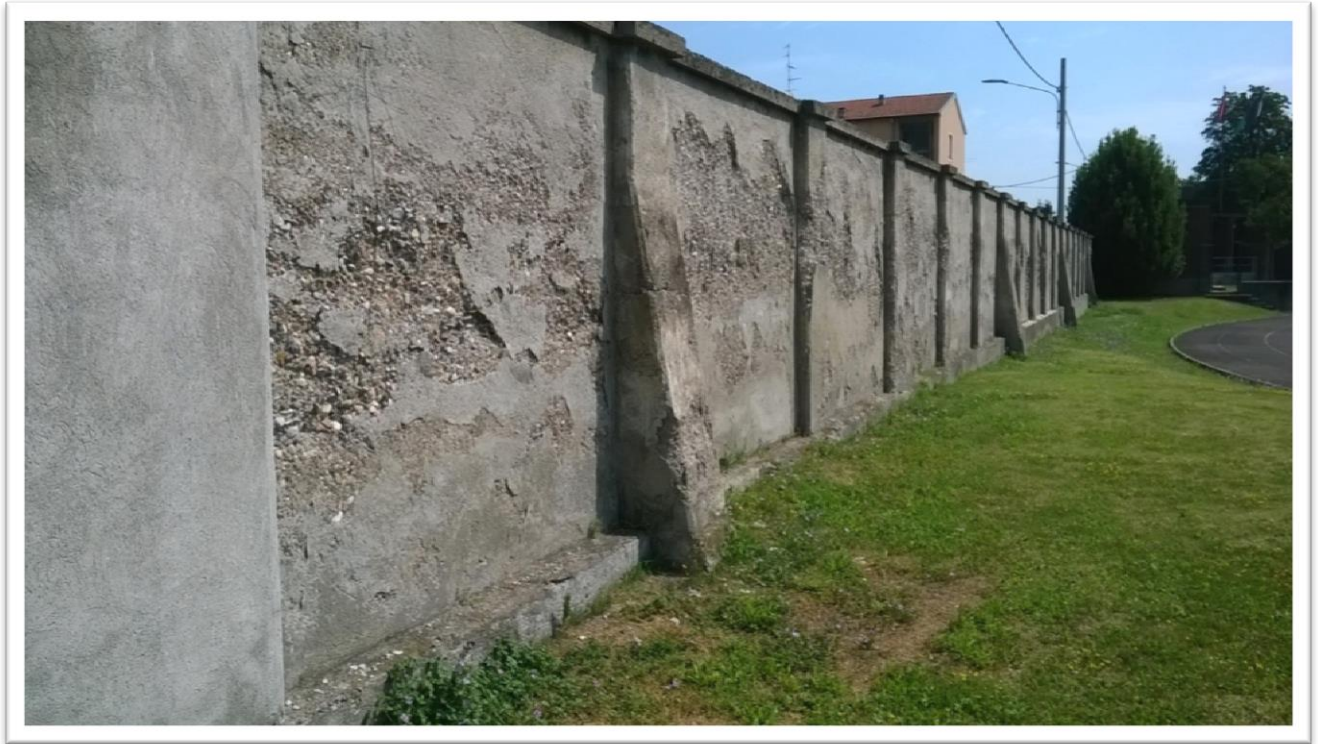
Figura 2 - lato interno recinzione via Cadorna
