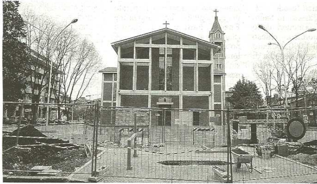
Il blocco dei lavori non è stato apprezzato: si teme che per la domenica di Pasqua non sia pronta la piazza rinnovata. Le critiche fioccano, il Comune procede tranquillo (foto Blitz)
