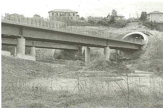
I cantieri della Tratta A sono ormai a buon punto. Le critiche feriscono il territorio (Archivio)
