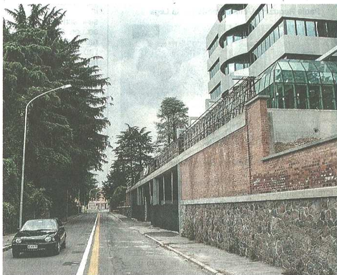
L'ex Peplos di via Bettinelli ospiterà comparti commerciali, residenziali e di servizi
