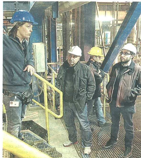
Dopo l'incendio di gennaio è tornata in funzione la Linea 2 dell'inceneritore
