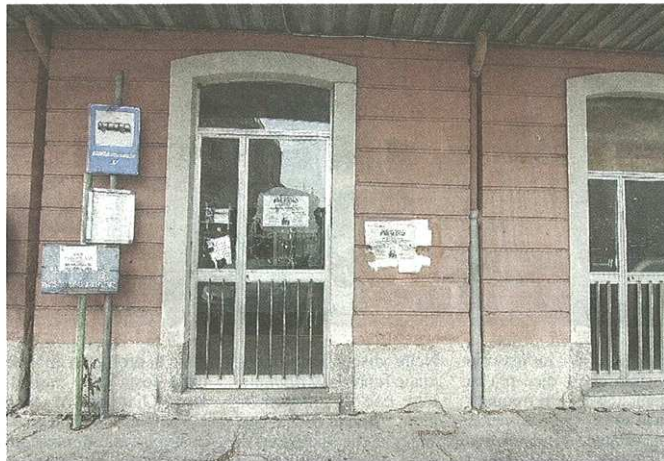
La vecchia biglietteria ferroviaria di via Pomini, coinvolta nella vertenza
