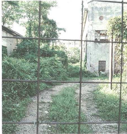
L'area si presenta in situazioni molto precarie (Blitz)
