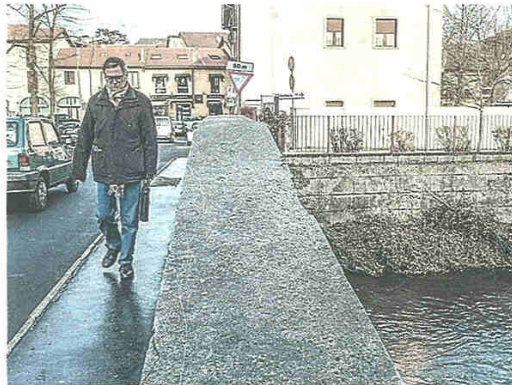
Il ponte sul fiume Olona a Castellanza: è uno dei cavalcavia coinvolti dall'opera di restyling
