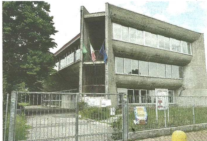
La scuola primaria è chiusa ormai da mesi, le piogge hanno provocato danni (Blitz)
