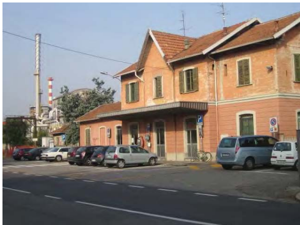
1.Parceggio, giugno 2007, veduta da via L. Pomini
