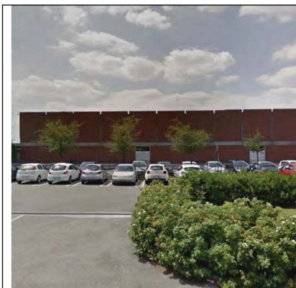
2. Parcheggio, veduta da est del parcheggio a sud
