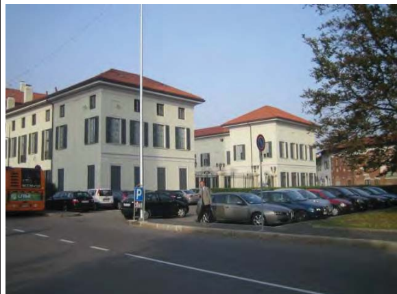
2. Parceggio, giugno 2007, veduta da viale Rimembranze
