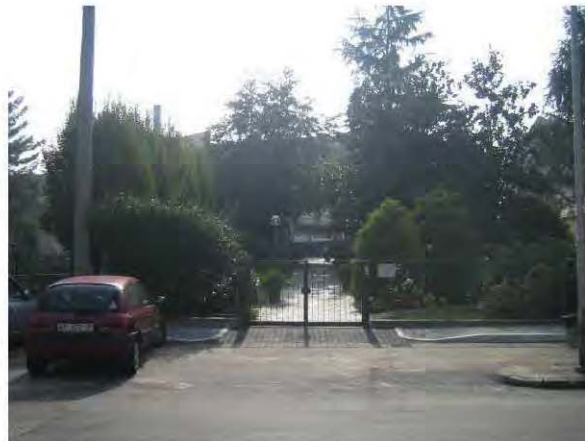
2.Scuola cantoni, giugno 2007, veduta dell'edificio principale da via Borsano
