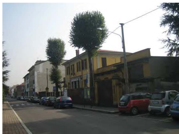
1.Scuola E.Fermi, giugno 2007, veduta dell'edificio principale da via Cantoni
