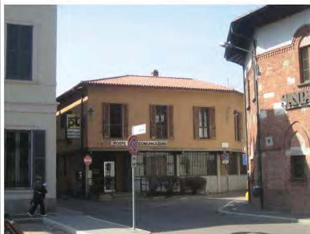
1.Ufficio Postale, giugno 2007, veduta da corso Matteotti
