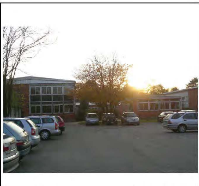
2.Scuola Leonardo da Vinci, giugno 2007, veduta dell'edificio principale da via Trento e Trieste
