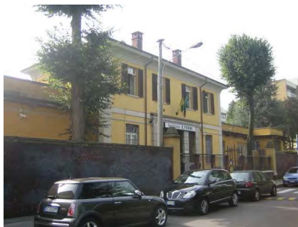
2.Scuola E.Fermi, giugno 2007, veduta dell'edificio principale da via Cantoni
