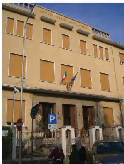
1.Scuola Maria Ausiliatrice, giugno 2007, veduta dell'edificio principale da via Card. Ferrari
