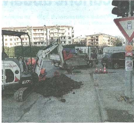
I lavori per il ripristino del mega impianto semaforico
