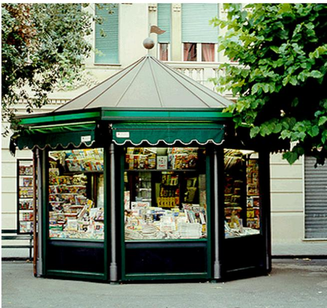
Edicola costruita su misura, con struttura portante in acciaio, trattamenti particolari con vernici che garantiscono durata alle intemperie (vernici ecologiche esenti da piombo), coperture impermeabilizzate, rivestimenti esterni in alluminio, serrande in lamiera zincata con serrature di sicurezza.
