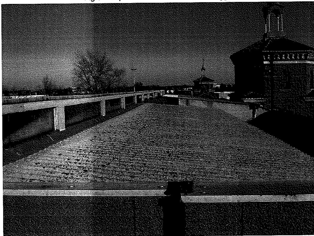
Fig.7 – Copertura in cemento-amianto oggetto di bonifica
