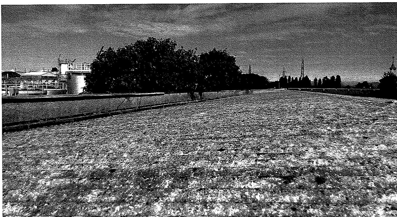
Fig.5 – Copertura in cemento-amianto oggetto di bonifica
