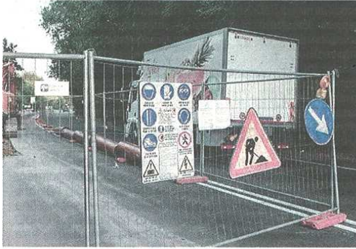
Viale Borri è intasato dal traffico a causa dei cantieri aperti
