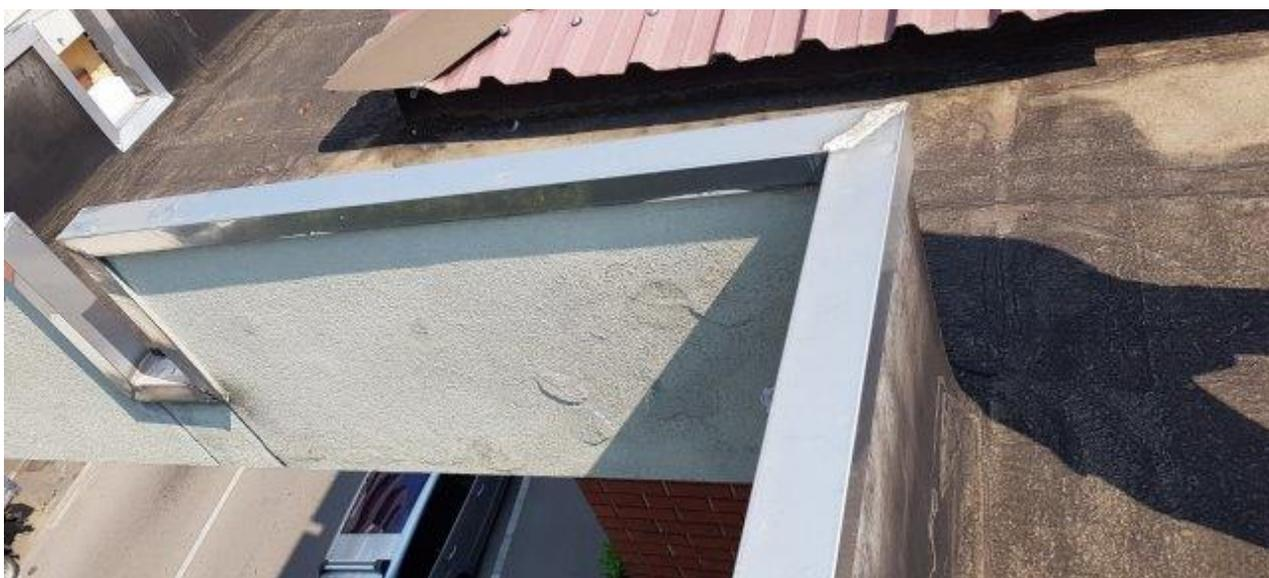
Tali elementi, previa impermeabilizzazione della gronda mediante doppia guaina bituminosa con rimozione e riposizionamento della lattoneria in sommità, devono essere trattati mediante passivazione dei ferri di armatura e ricostruzione delle parti deteriorate. La porzione verticale esterna della gronda verrà quindi rasata (doppia mano di rasante con interposta rete di fibra) e finita con tonachino colorato in pasta. Il sottogronda, opportunamente rappazzato, verrà tinteggiato.
