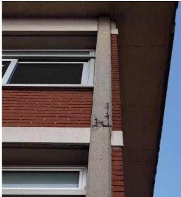
Le infiltrazioni hanno interessato anche le facciate ove sono evidenti fenomeni di sfioritura dell'intonaco e delle pitture esistenti, per tale ragione, per preservare le murature si interviene mediante completa pitturazione delle facciate, previo ripristino della superficie ed imprimitura.
